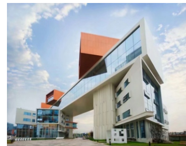
仙桃数据谷实训基地
