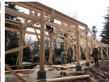
园林建筑施工现场教学
