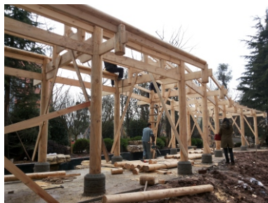
图135 园林建筑施工现场教学
