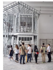
轻钢结构装配式施工实验室
