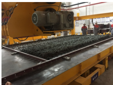
装配式施工实训
